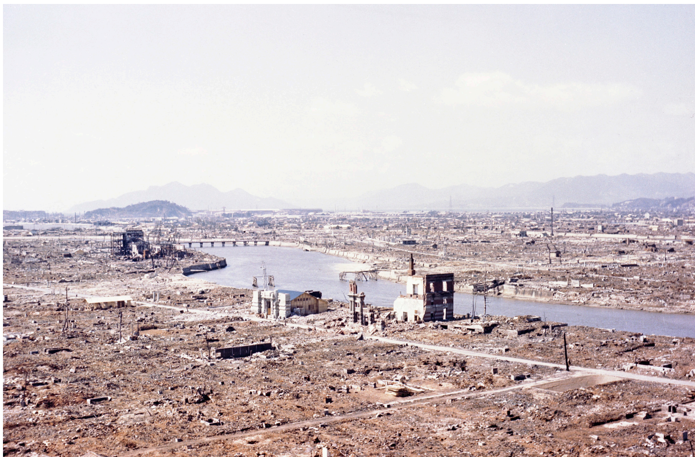
Vue du centre d'Hiroshima, atteinte le 6 août 1945 par une bombe nucléaire américaine de 13 kilotonnes. Une bombe tactique russe peut peser 350 kilotonnes | Image: Keystone
