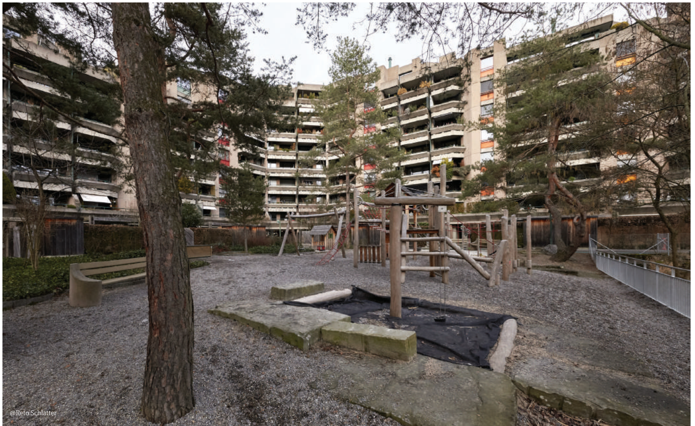
Au Brunaupark de Zurich, ce sont 405 appartements construits dans les années 80 et 90. Le propriétaire, le Credit Suisse, a décidé d'en détruire 240 pour les reconstruire.
