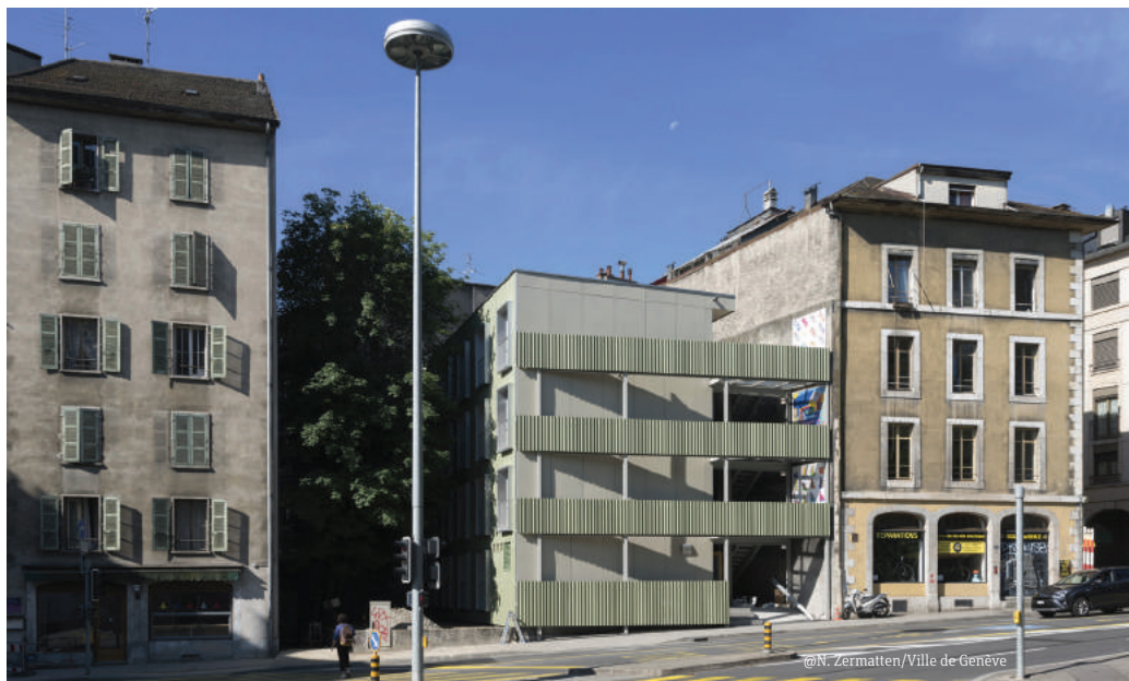
Dix-neuf studios ont été créés dans des structures provisoires sur un parking de Genève.
